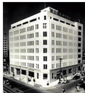
大正海上本社ビル
