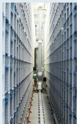
自動倉庫設備
