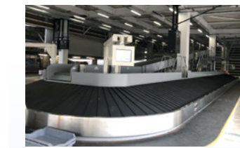
成田国際空港 第1ターミナル南棟
